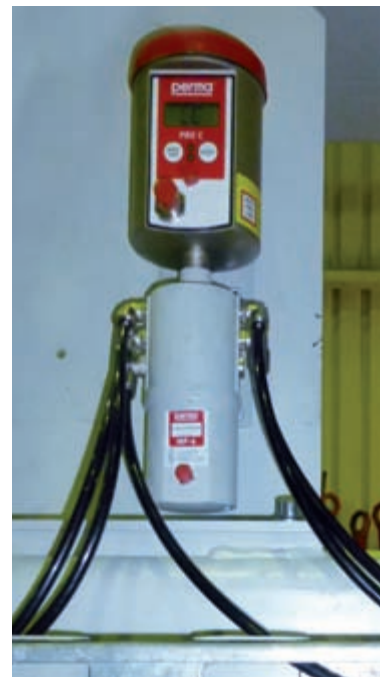
ASE Zentral-Schmiersystem elektrisch
