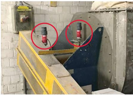
Promazávání stojanových ložisek větracího zařízení
