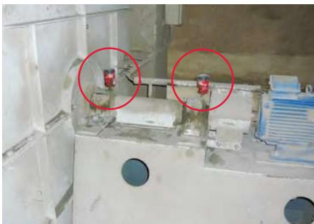
Promazávání stojanových ložisek hřídele ventilátoru
