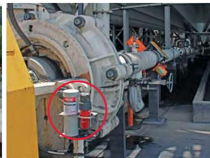
Promazávání ložisek / těsnění čerpadla
